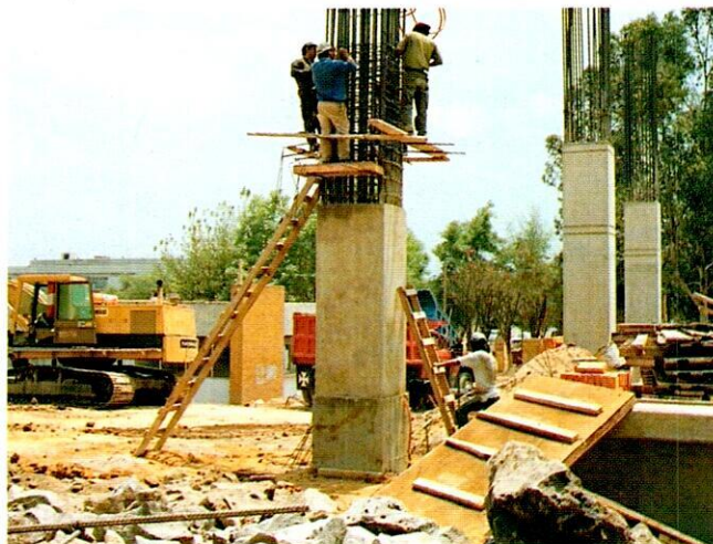
Desarrollo de Obra Civil en Ciudad Universitaria.
