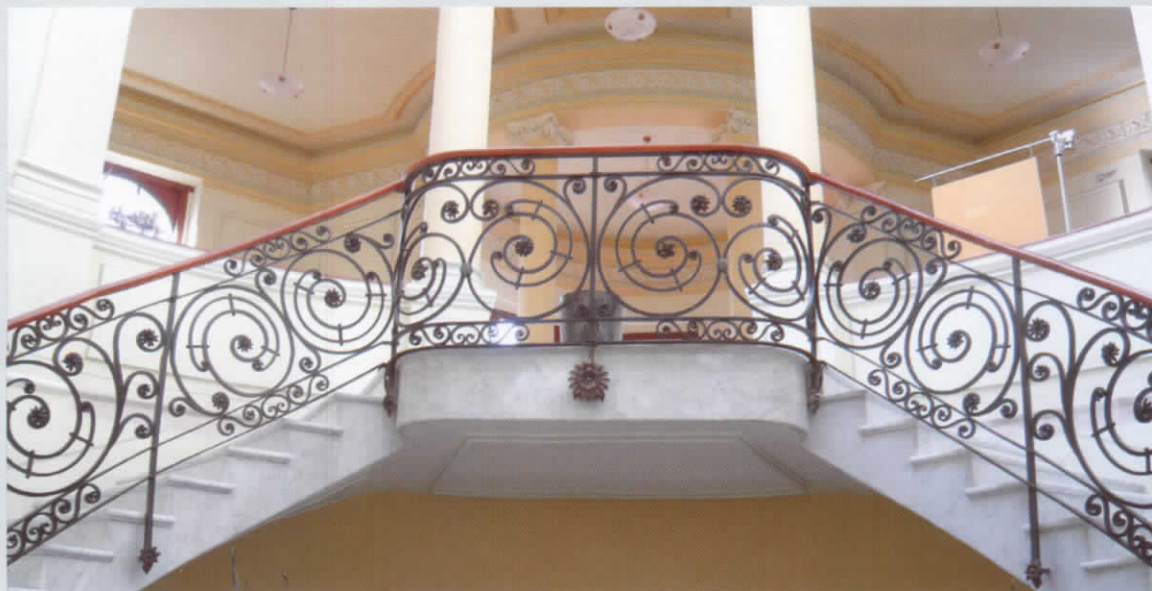
Barandal de la escalera central del Palacio de la Autonomía
